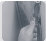
Encaixe a mangueira na conexão de gás
