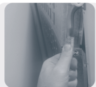
Encaixe a mangueira na conexão de gás
